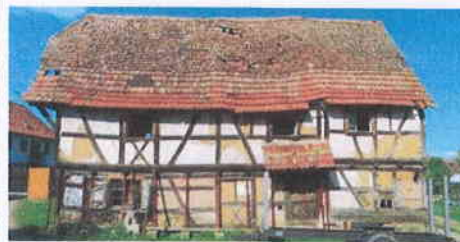
À Ohlungen, une maison du XVII e siècle menacée de s'effondrer : elle sera remontée à La Wantzenau. Photo DR
